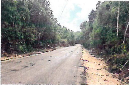
FOTO No. 6 Rehabilitación del camino entronque a San José Segundo a San Felipe Berriozábal del km 0+000 al km 4+000
