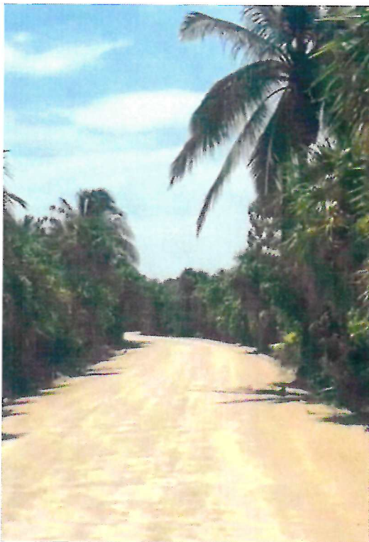
FOTO No. 1 Rehabilitación del camino Costero a nivel de terracerías tramo Tulum - Punta Allen del km 17+000 al km 37+000
