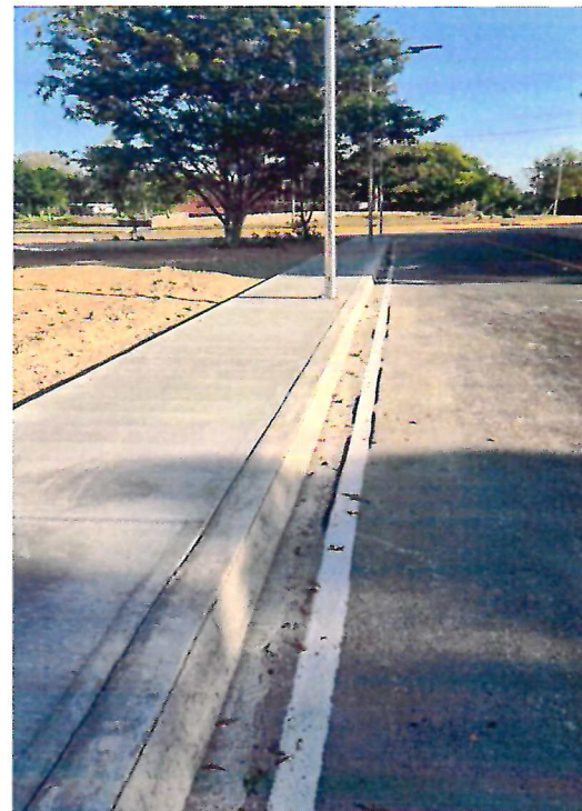
FOTO No. 4 Construcción de vialidad para estacionamiento de vehículos mobi en la localidad de Chetumal 37+000
