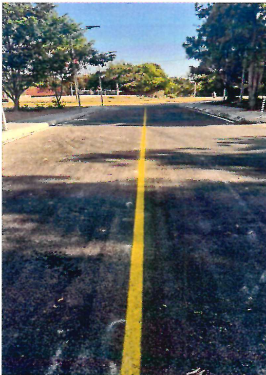
FOTO No. 3 Construcción de vialidad para estacionamiento de vehículos mobi en la localidad de Chetumal 37+000
