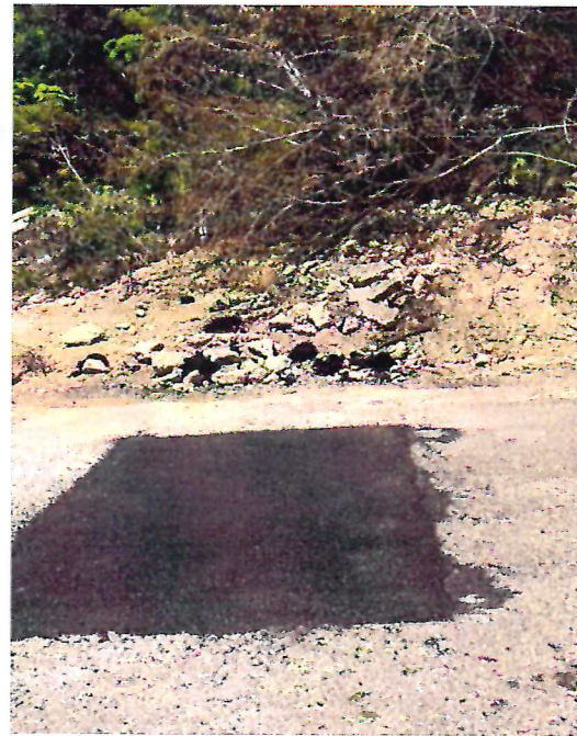
FOTO No. 8 Rehabilitación del camino entronque a San José Segundo a San Felipe Berriozábal del km 0+000 al km 4+000
