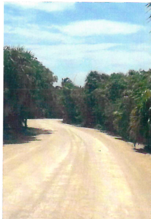
FOTO No. 2 Rehabilitación del camino Costero a nivel de terracerías tramo Tulum - Punta Allen del km 17+000 al km 37+000
