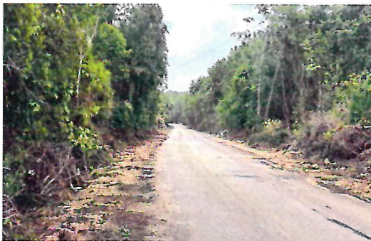
FOTO No. 7 Rehabilitación del camino entronque a San José Segundo a San Felipe Berriozábal del km 0+000 al km 4+000
