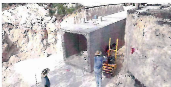
FOTO No. 5 Rehabilitación de alcantarilla de la carretera Ucum – La Unión en el km 31+000 entre las localidades de Sabidos y Pucté.
