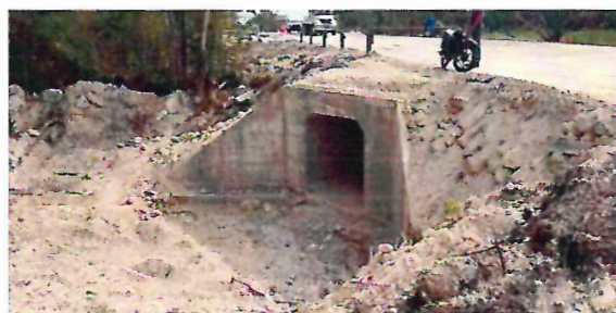
FOTO No. 6 Rehabilitación de alcantarilla de la carretera Ucum – La Unión en el km 31+000 entre las localidades de Sabidos y Pucté.
