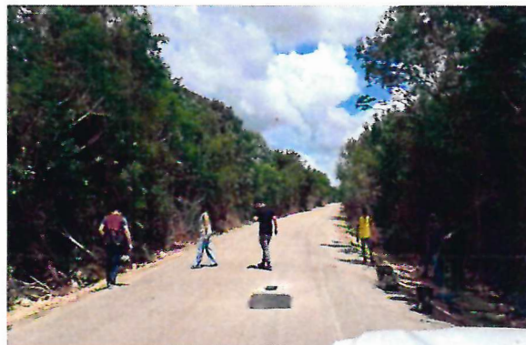
FOTO No. 1 Rehabilitación del camino entronque a San José Segundo a San Felipe Berriozábal del km 0+000 al km 4+000.
