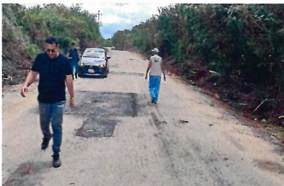
FOTO No. 1 Rehabilitación del camino entronque a San José Segundo a San Felipe Berriozábal del km 0+000 al km 4+000.
