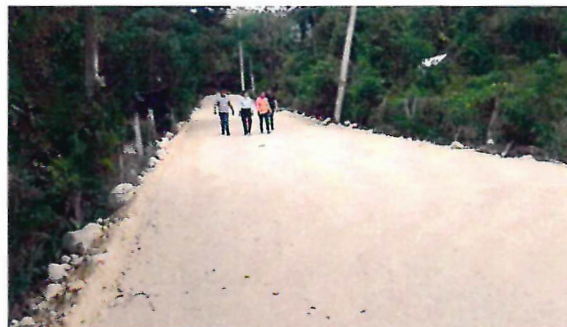
FOTO No. 4 Rehabilitación de calles de la localidad de Jesús González Ortega.
